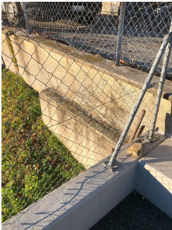
Foto 11: vista muro di rinforzo esistente
