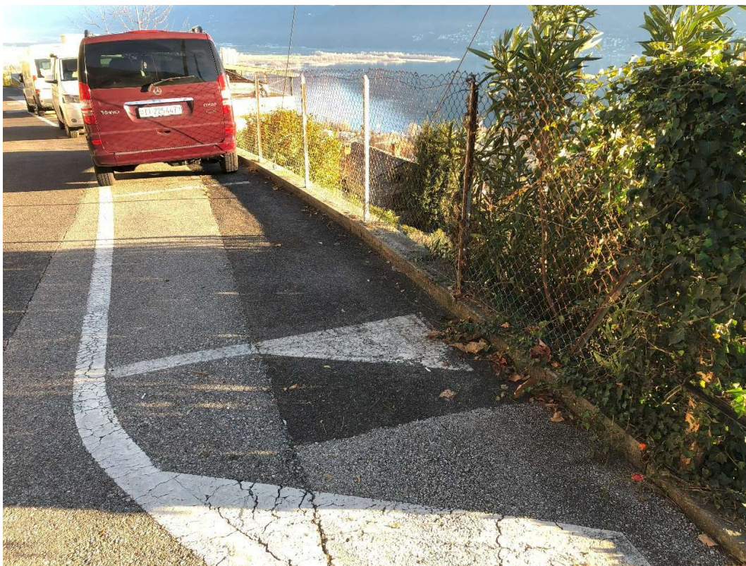
Foto 1: vista da ovest, inizio strada
